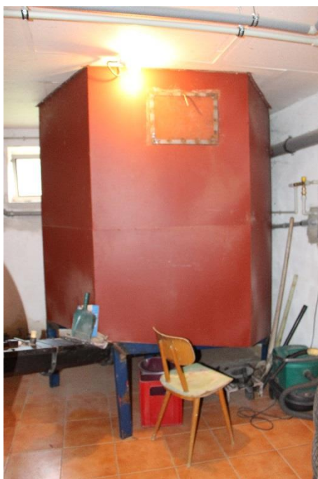
Figura 4 - Silo di carico esagonale e particolare della finestra di carico combustibile
